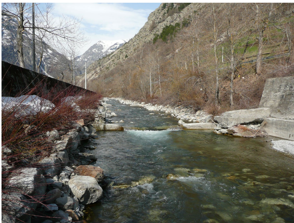
Fig. 7.3: soglie di fondo da eliminare in quanto elemento di disturbo per la corrente
