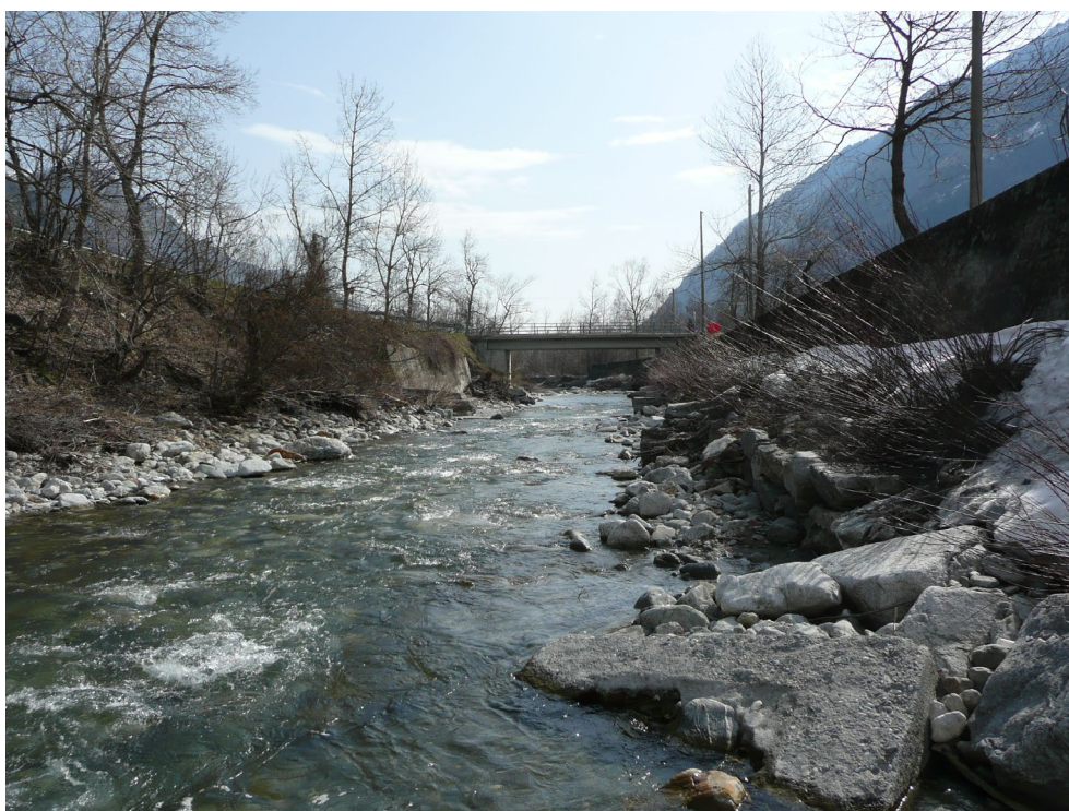
Fig. 7.4: pennelli inefficienti da eliminare in quanto elemento di disturbo per la corrente (in basso a destra)
