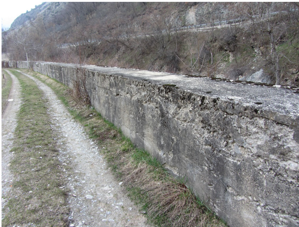
Fig. 7.6: muro d'argine in sponda destra oggetto di possibile crollo in caso di evento di piena
