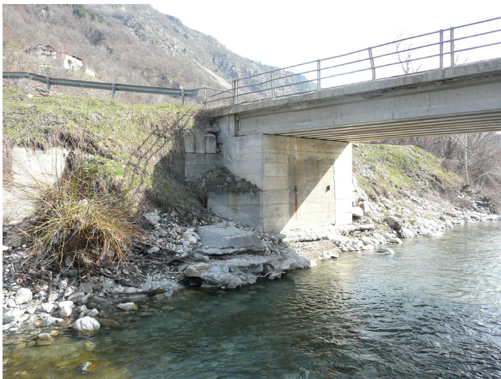
Fig. 7.2: ponte per località Roviera che verrà sostituito con un attraversamento con luce maggiore
