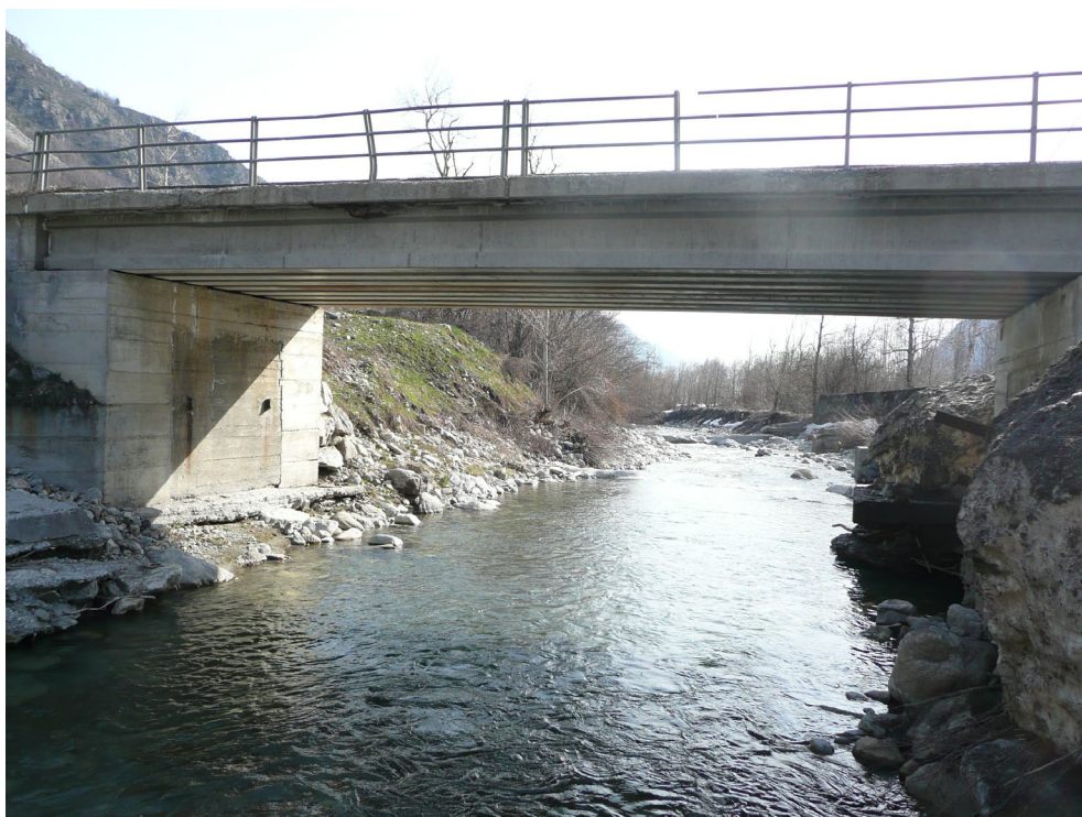
Fig. 7.1: ponte per località Roviera che verrà sostituito con un attraversamento con luce maggiore
